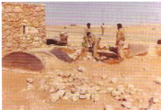
Reparación y acondicionamiento de casamatas. Al fondo, el capitán Esteban Gutiérrez Sánchez inspeccionando los trabajos.
