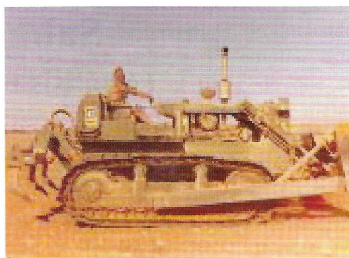
Pala mecánica de Ingenieros allanando los campos de tiro
